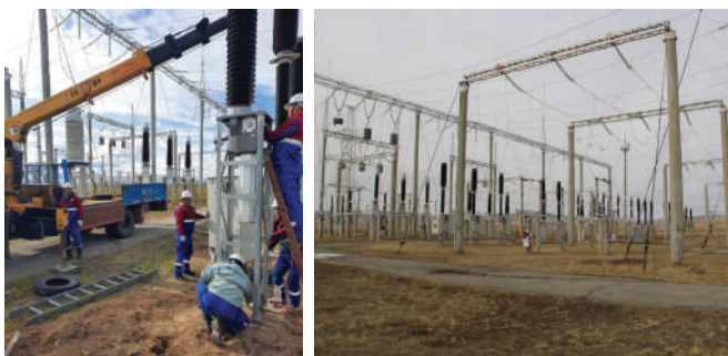
Зураг-8 Багануур дэд станцын схем өөрчлөлтийг хийж байгаа бригад
