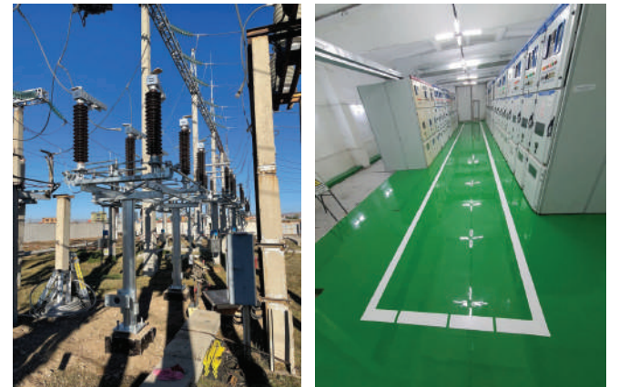
Зураг-10 GW4A-126DW/200 маркийн хуурай салгуур, Яармаг дэд станцын 10 кВ ячеийкуудын шинэчлэл
