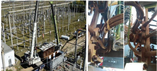
Зураг-1. Трансформаторын туслах эд, ангиудыг салгаж, ороомгийн бэхлэгээнд засвар хийсэн байдал
